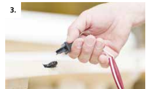
3. Placer le clip de pré-serrage sur l'outil d'introduction
